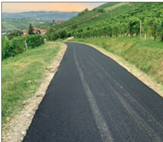
Lavori strada Valeirano dopo nuovo asfalto
