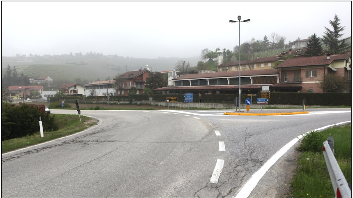
Figura 2: Panoramica area ripresa dal ponte sul T. Seno d'Elvio.
