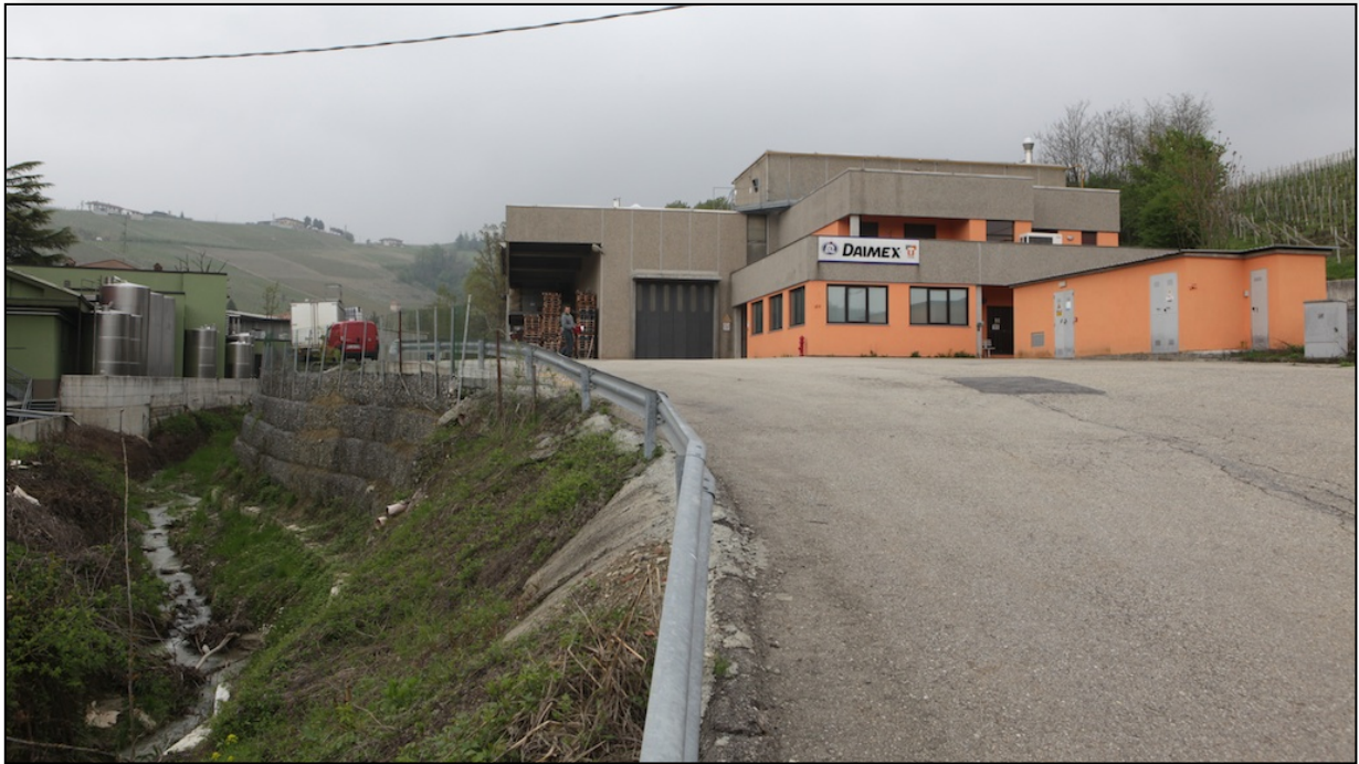
Figura 2: Panoramica area ripresa in corrispondenza dell'accesso da strada carrabile.
